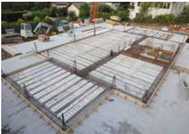
SOLAIO IN PREDALLES
